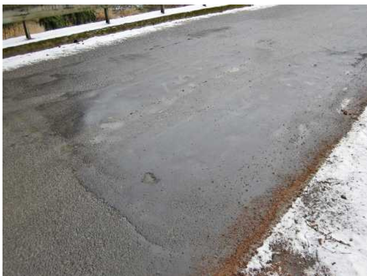
Poruchy v krytu vozovky v poli 1.
