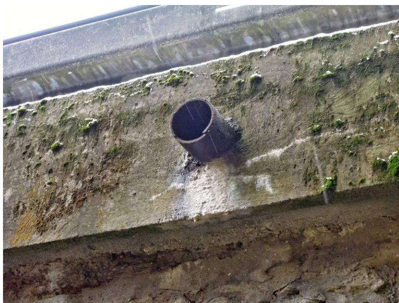
pohled na vyústění odvodňovací trubky na vnější straně římsy; u odvodnění na levé straně 1.pole dochází k průsaku pod trubkou, tvoří se výluhy
