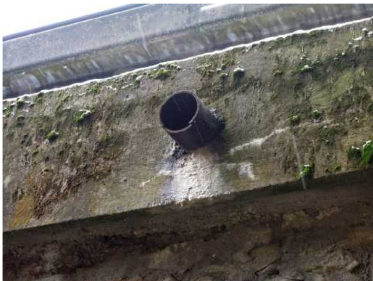
Levá římsa v 1.poli, vyústění trubky odvodnění vně římsy, výluhy pod trubkou.
