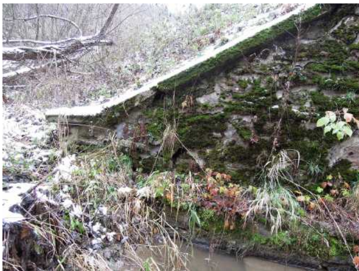
Levé křídlo opěry 3. Obdobný stav, zdivo až rozvolněné.
