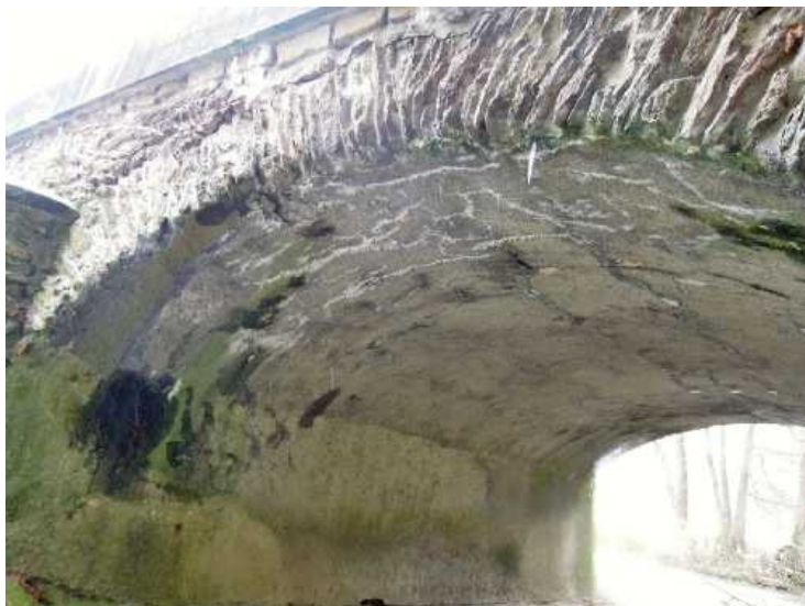
Pole 1, levá strana, průsaky, trhliny s výluhy na pohledu klenby.
