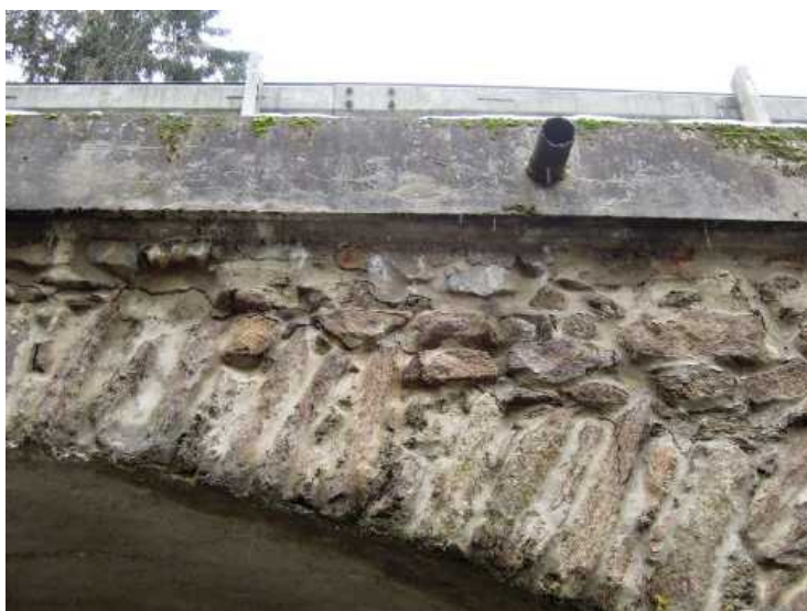
Pole 2, pravá čelní zeď, průsaky, znovu porušené opravované spárování čelní zdi.
