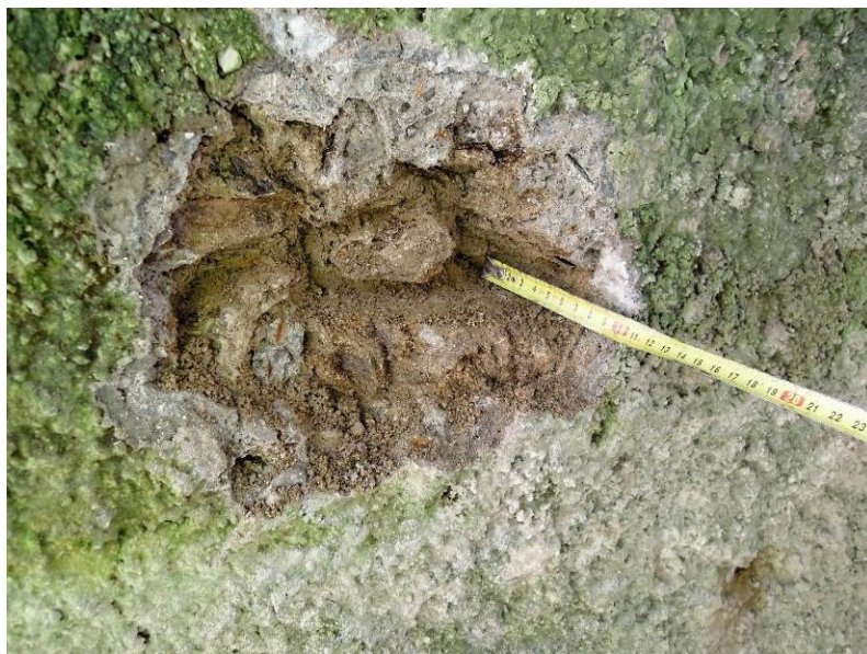
sonda do spáry zdiva - líc pilíře 2 z 1.pole
