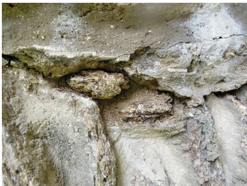
sonda do spáry zdiva - levá strana 1.pole u vrcholu, spára v patě čelní zdi mezi čelní zdí a horním lícem klenby
