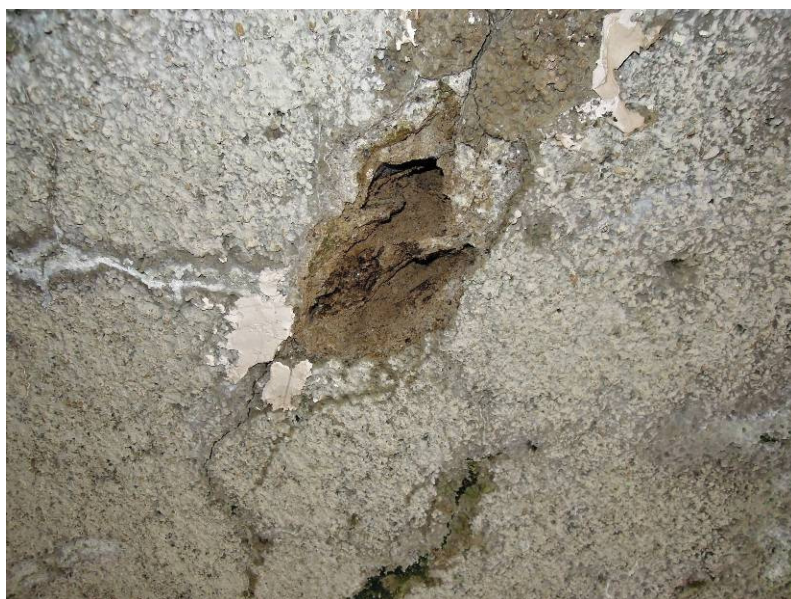
sonda do spáry zdiva - 1.pole, v místě podélné trhliny ve vrcholu ~1.5m od levé hrany
