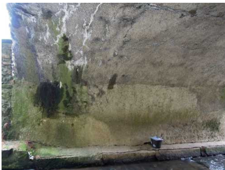
Pilíř P2, levá strana 1.pole, poruchy s průsaky na podhledu části klenby a v její patě.
