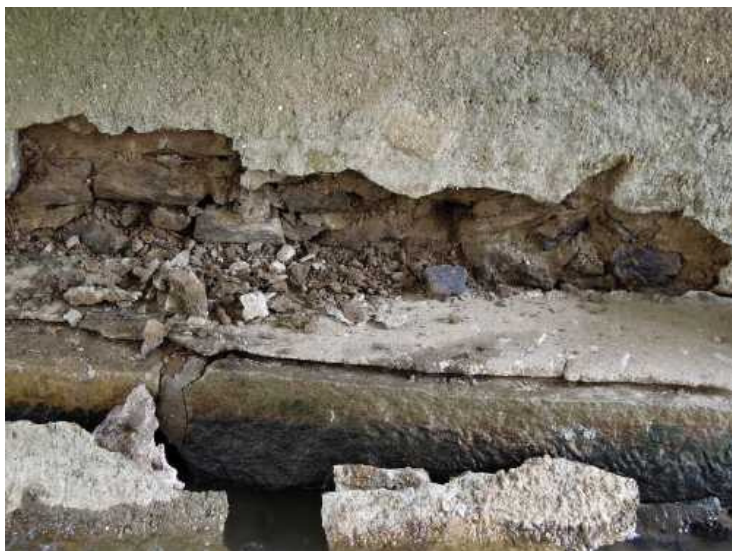
Dtto, větší rozsah poškození po odstranění vrstvy torkretu, zcela rozpadlá spárová malta.
